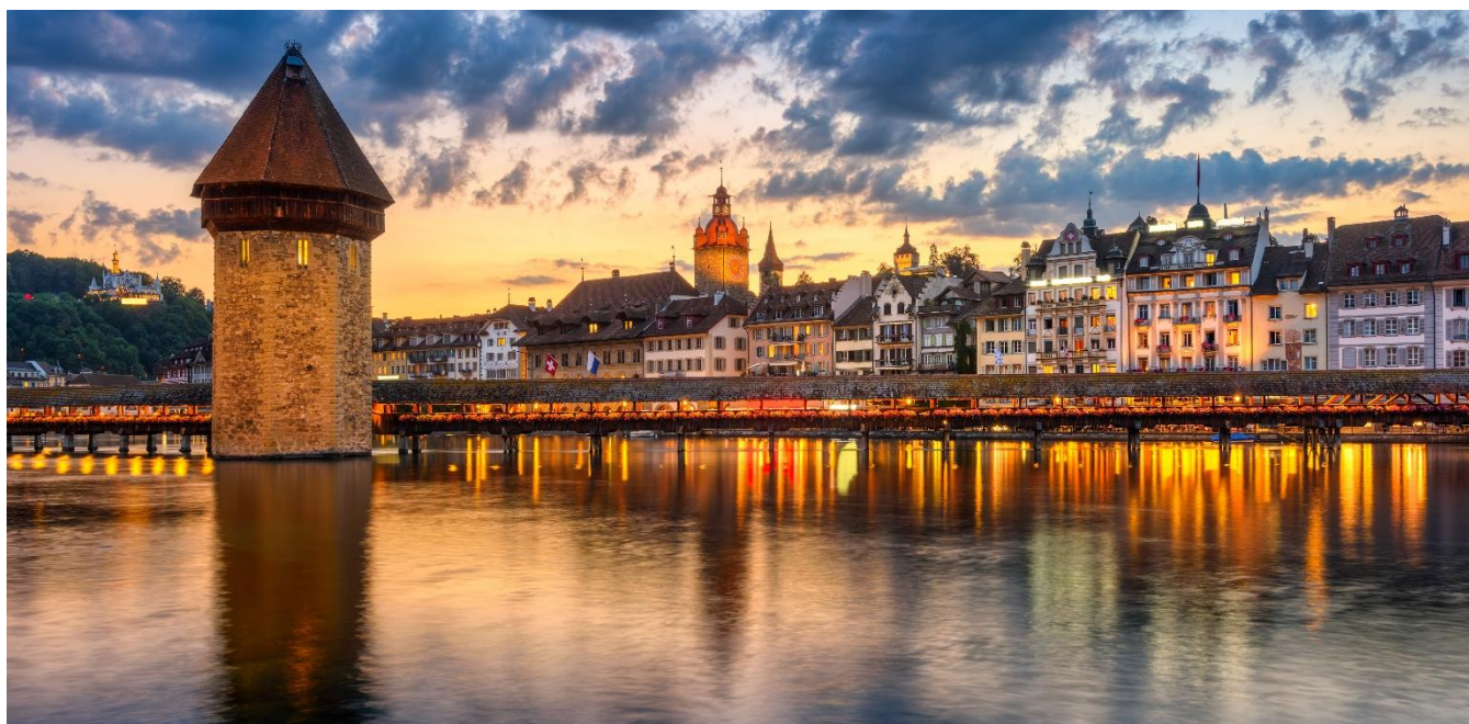
Ponte da Capela, Lucerna, Suíça
